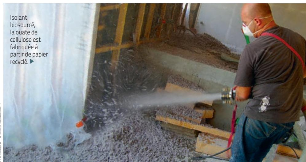
Isolant biosourcé, la ouate de cellulose est fabriquée à partir de papier recyclé. ▶
