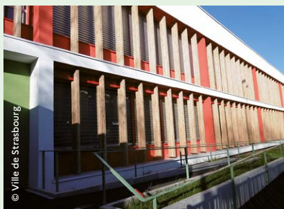
Façades de l'école Louvois à Strasbourg, après les travaux d'isolation acoustique et thermique
