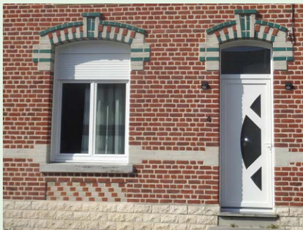
Exemple d'isolation acoustique et thermique réalisée grâce au dispositif Éco-bruit
